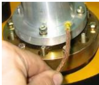
Câble de terre externe
