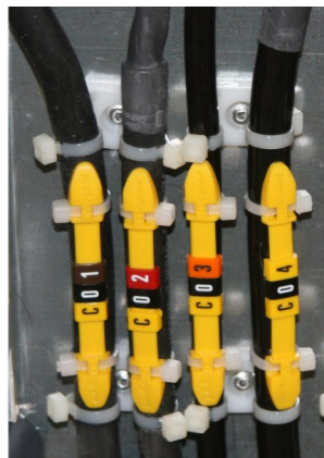
A l'intérieur du coffret électrique
