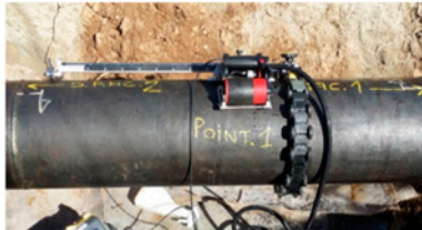
FIGURE 7 : Inspection d'une tuyauterie avec scanner Beltman à chaîne.
