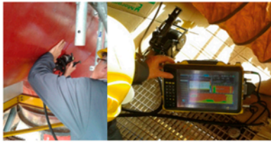
FIGURE 2 : Inspection de conduites d'évacuation de fumées avec la Wheel Probe 10 MHz.
